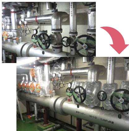
蒸気バルブ類の保温
