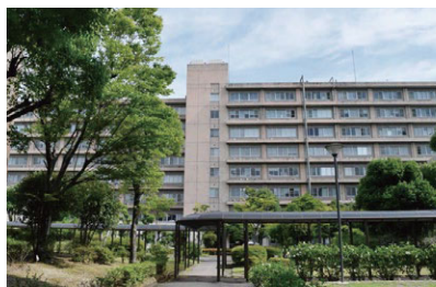
基礎・臨床研究棟
