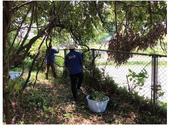
③⑬フェンスに巻き付いた蔓の除去作業
