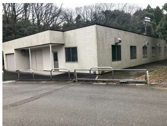
㉓作業後の備蓄庫外観
