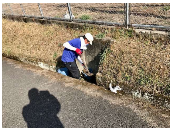
⑯土砂の除去作業
