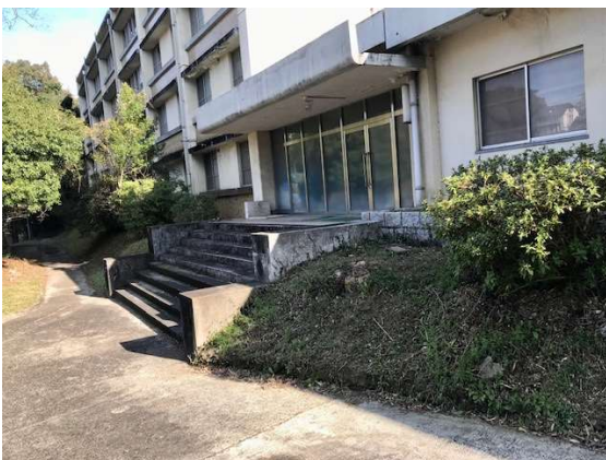
③⑭作業後の玄関付近
