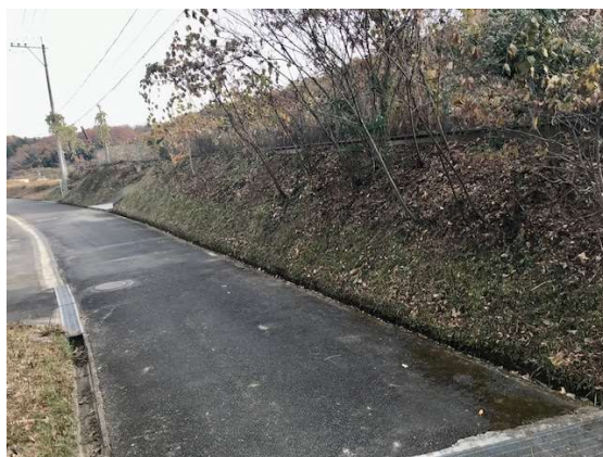
⑫作業後(崩落防止のため急な法面の木は残します)
