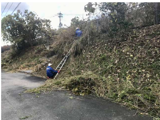
⑪駅からキャンパスへ向かう道路法面の草刈作業
