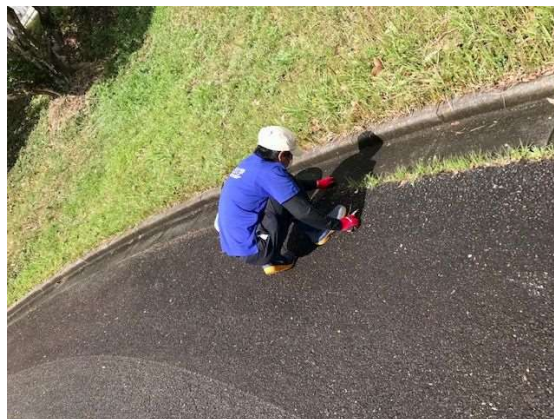
③③アスファルトに浸食した芝の除去
