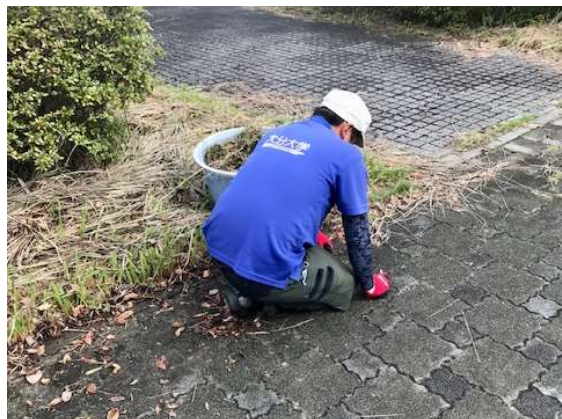
③②インターロッキングに浸食した芝の除去
