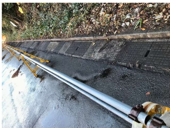
㉔道路側の作業はほぼ終了
